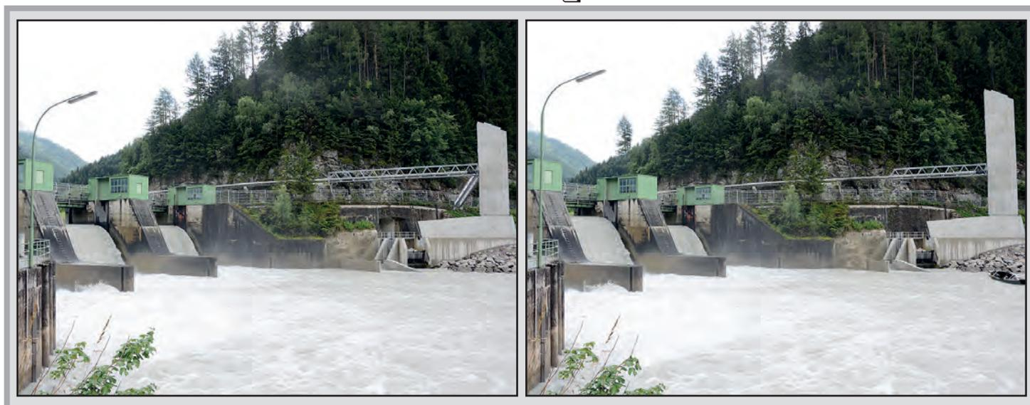
In den Jahren 1953 bis 1956 wurde das Kraftwerk Imst, ein Laufkraftwerk, errichtet. Damit hängt auch das Wehr in der Runserau zusammen. Das dort aufgestaute Wasser wird durch einen 12 Kilometer langen Druckstollen nach Imst geleitet und überwindet dabei eine für ein Laufkraftwerk ungewöhnliche Fallhöhe von 143,5 Metern. 2015 wurde das Wehr um den ersten Fischlift Österreichs erweitert.
