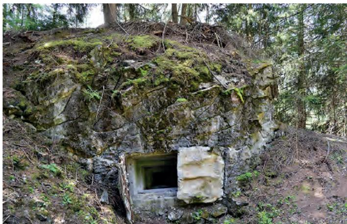
Die errichteten Bunker wurden in besonderer, hervorragender Bauweise ohne Stahl, dieser wurde für die Waffenproduktion benötigt, in Beton erbaut bzw. in den Fels gegraben. Die Mauerstärke lag zwischen vier und sieben Metern. Anschließend wurden die
