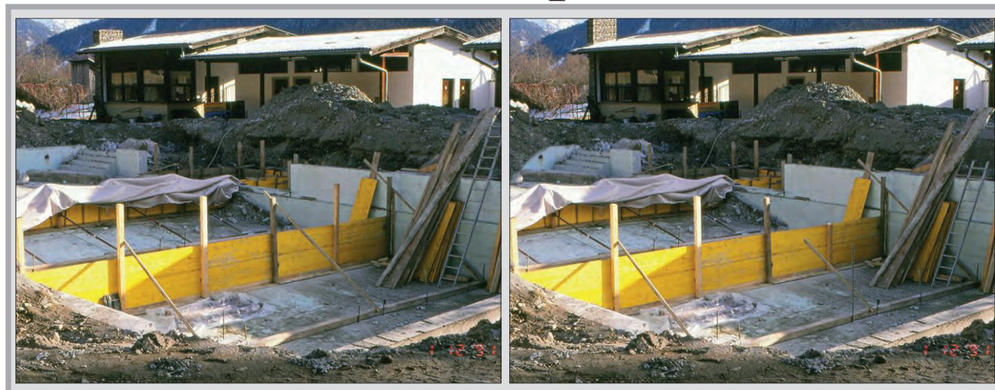
Vor 30 Jahren gab es keine Badesaison im Fließener Schwimmbad. Das alte Betonbecken hatte ausgedient und ist durch ein Edelstahlbecken ersetzt worden. Wie auf dem Foto zu erkennen ist, wurde das neue Becken in das alte eingesetzt und mit einer Rutsche ergänzt. Nach drei Jahrzehnten ist auch diese aus Sicherheitsgründen entfernt worden.
